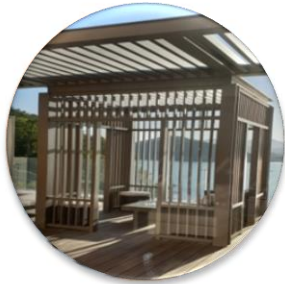
파고라 제작 및 시공
