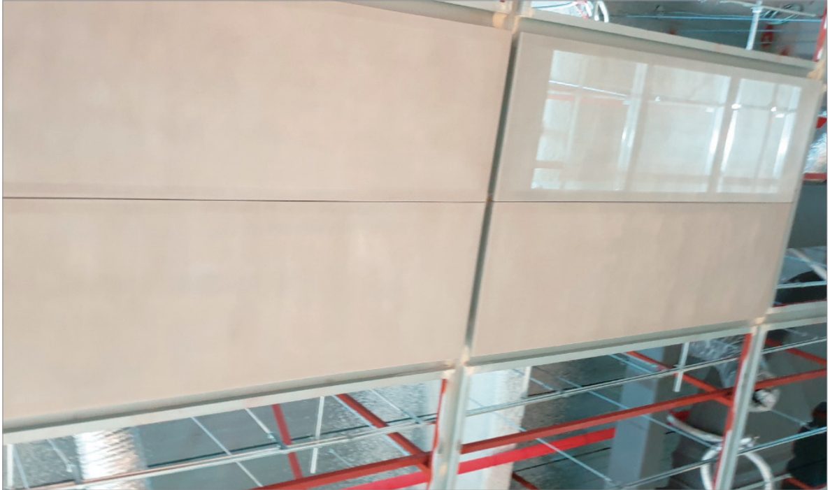
AL 타공판 천정 시공 모습
